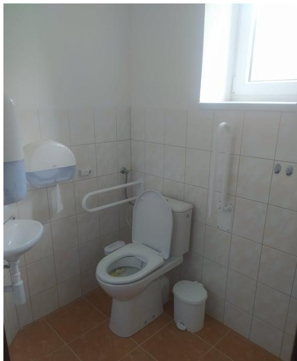
Nové bezbariérové WC
